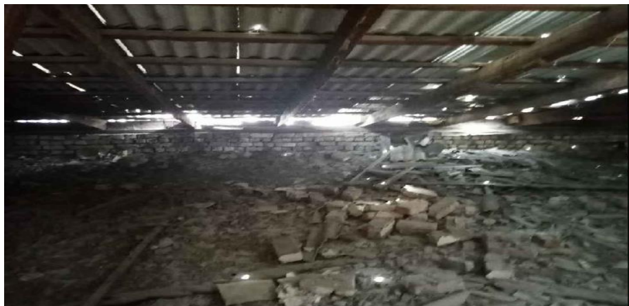
Фото: Состояние деревянных конструкции со стороны чердачного помещения корпуса актового и спортивного зала
