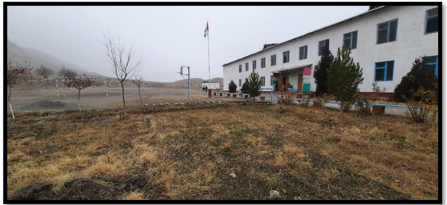
Фото участка подпроекта CSP-2B-34 место для строительства резервуара на 50 куб.м
