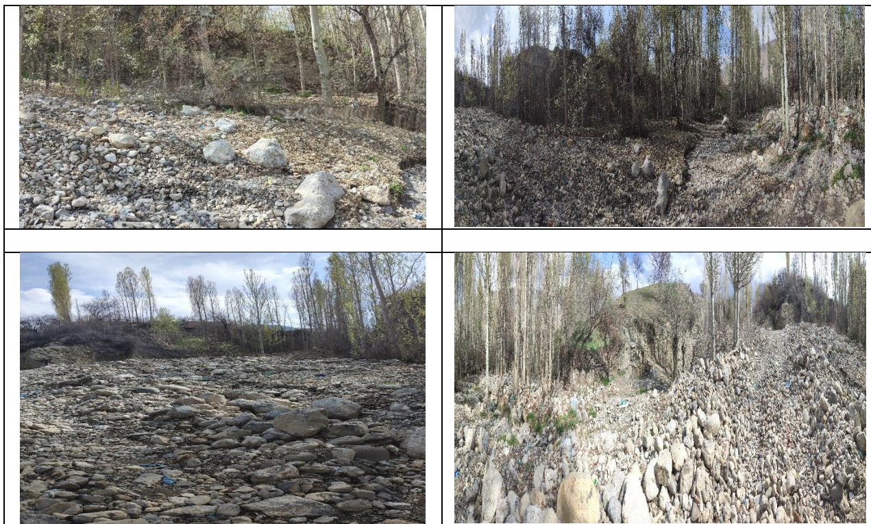
Фото участка канала для реализации подпроекта CSP-2B-08
