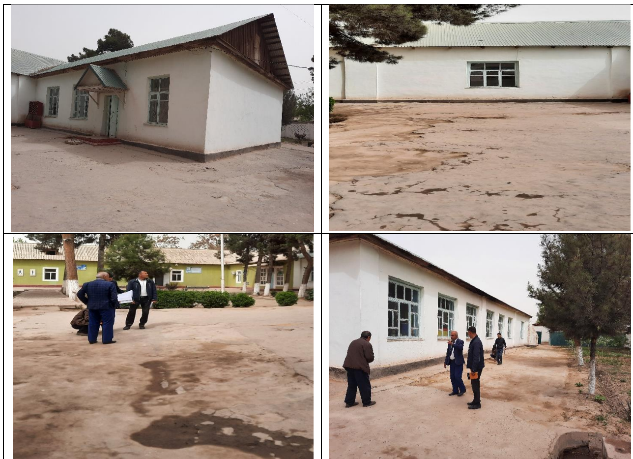
Фото участка для нового двухэтажного учебного корпуса на 7 классов
