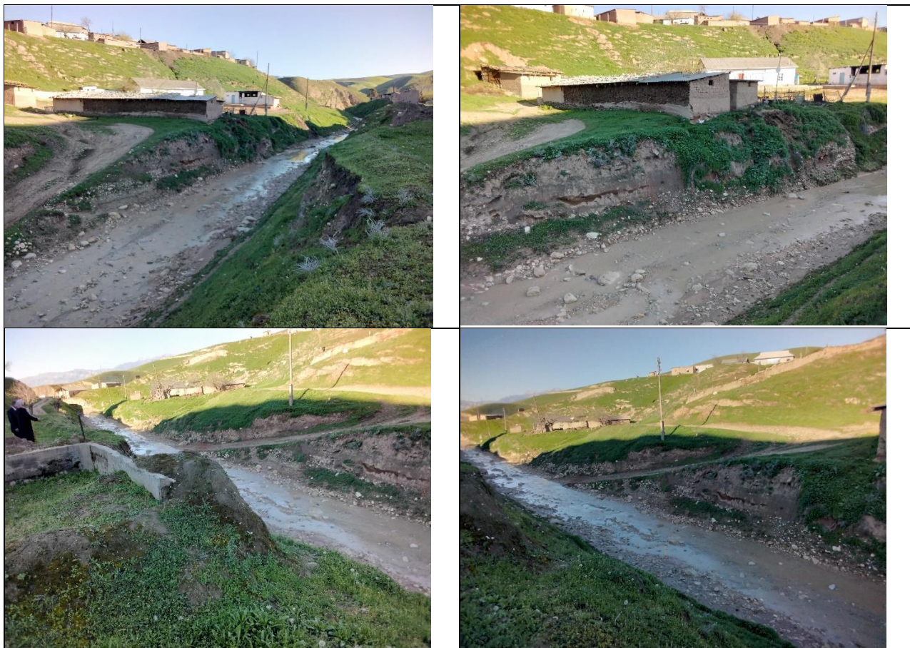
Фото участка для строительства моста
