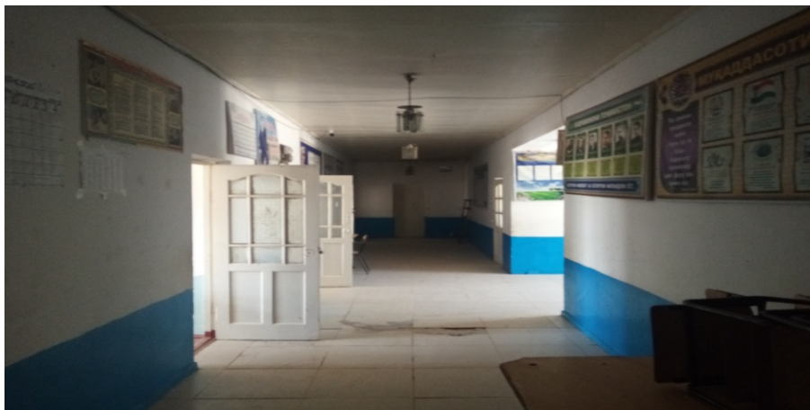
Фото: состояние вестибюля СШ№36 села Розикобод
