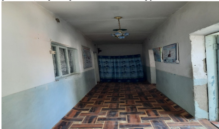
Фото: Состояние внутренних помещений
