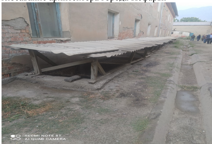
Фото: Состояние кровли учебных корпусов сверху
