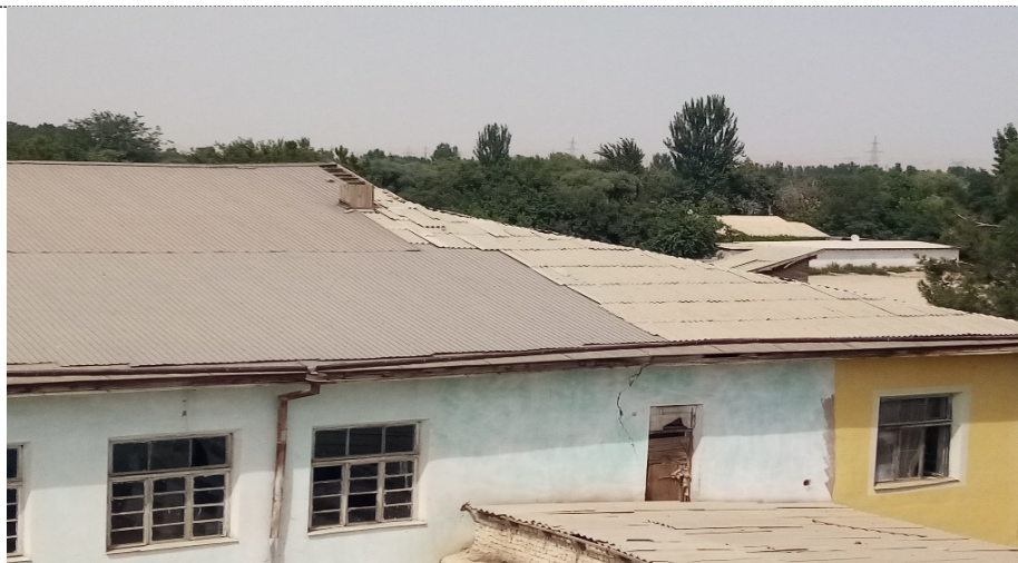
Фото: Состояние кровли учебных корпусов сверху
