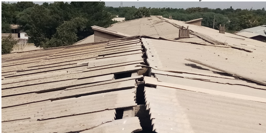
Фото: Состояние кровли учебных корпусов сверху
