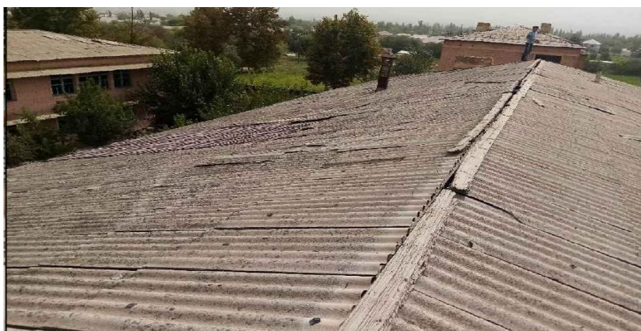
Фото: Состояние кровли учебных корпусов сверху
